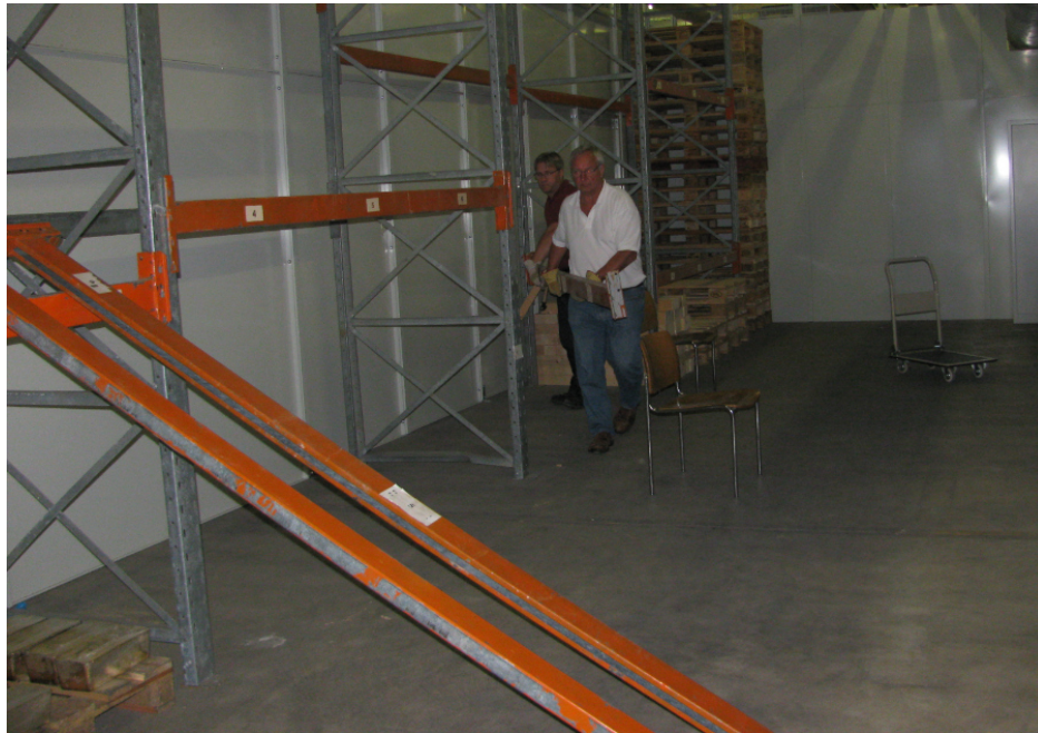
Abb. 2: Abbau der Hochregale, in denen früher Technologiemetalle lagerten.
